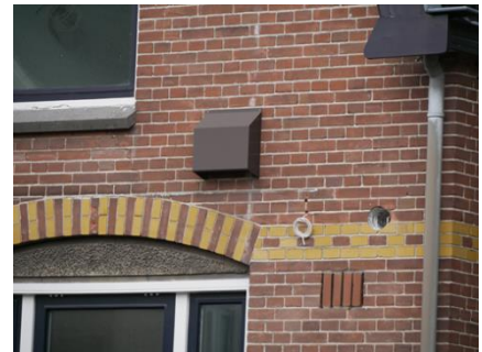
De zichtbare aanwezigheid van geluidsmaatregelen is een teken dat de sanering gereed is
