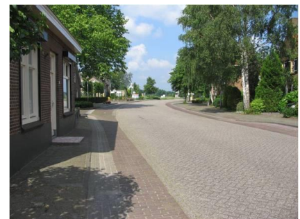
De Eindstraat in Drunen is een stuk stiller geworden. Naast diverse ontmoedigende maatregelen voor het doorgaand verkeer, is het wegdek vervangen door geluidsreducerende klinkers. Er is voor klinkers gekozen om het verblijfskarakter van de weg te accentueren.
