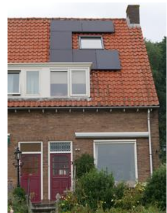
Zijn er mogelijkheden voor geluidsisolatie in combinatie met thermische isolatie?
