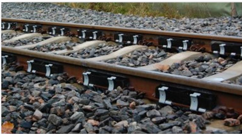
Figuur 16 Een voorbeeld van de bronmaatregel raildempers. Dit zijn de zwarte rubberen blokken die in dit geval tegen de rails worden geklemd.
