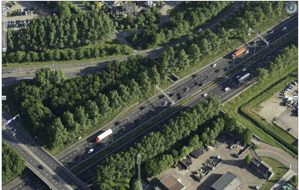
Figuur 5 Ligging viaduct + terugsteekhaven (gezien vanuit noordzijde) bron: Cyclomedia
