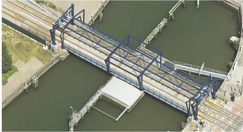
Figuur 13 Staal-betonnen draaibrug (2 dB toeslag) over de Binnenhaven te Maassluis.
