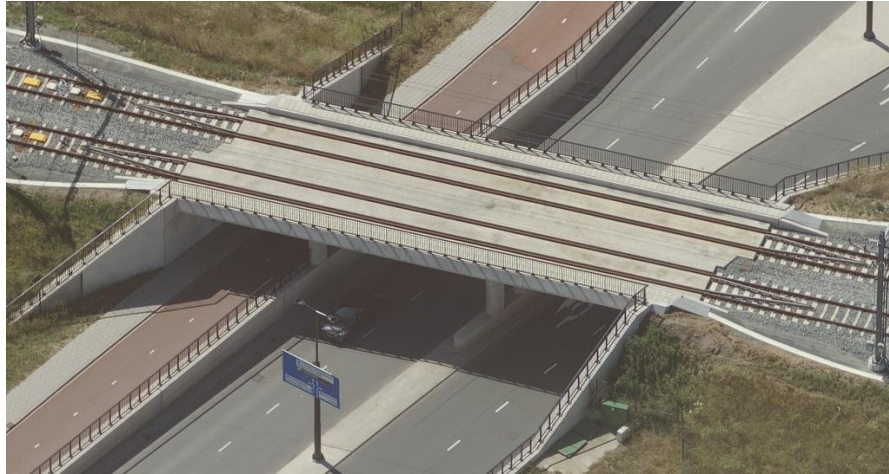
Figuur 6 Spoorbrug over de Marathonweg te Vlaardingen.
