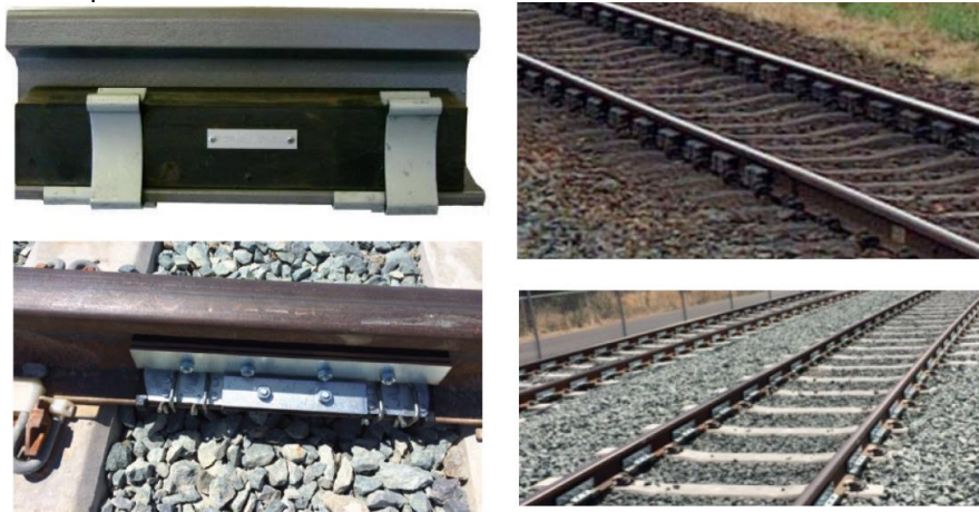
Figuur 9 Twee types raildempers die minstens 2,5 dB geluidreductie geven (CTRD en VICON AMSA).
