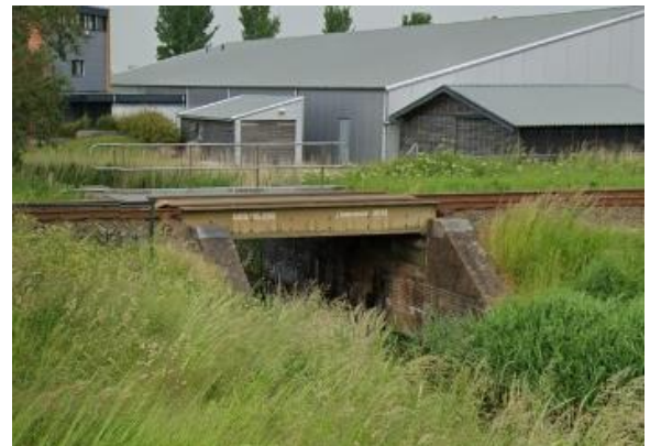
Figuur 9 - Stalen brug bij Cluster 1 en 2 (bron: Google maps)
