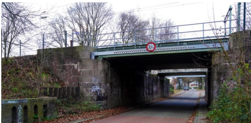
Figuur 1 Zuidelijke spoorbrug over de Louis Regoutstraat te Weert.
