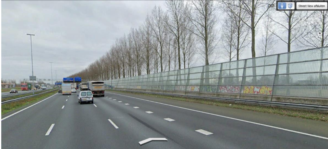
Afbeelding 1.3 Bestaand geluidsscherm zuidzijde A16 ter hoogte van LPM
