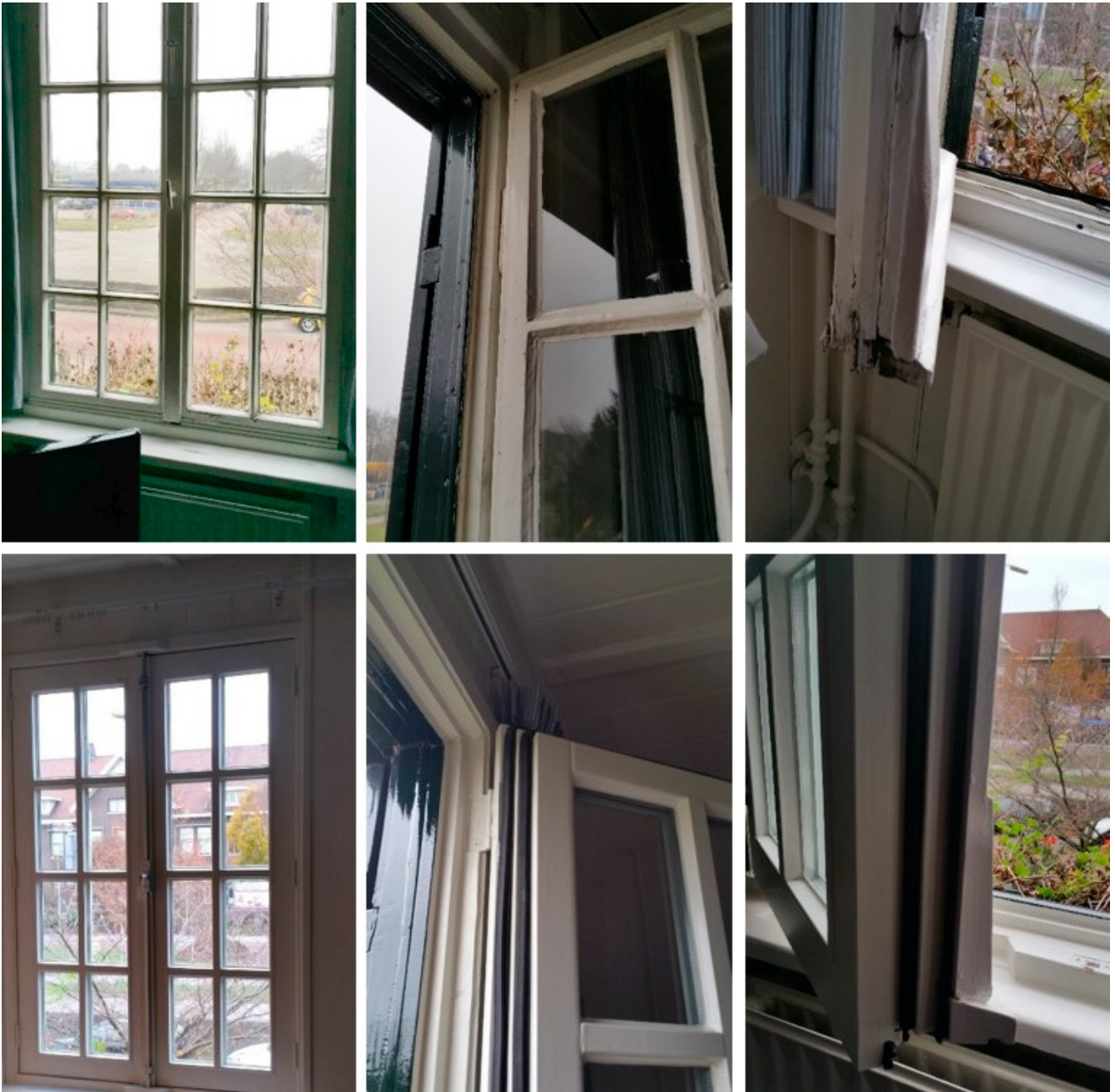
Raam voor (boven) en na (onder) gevelisolatie
