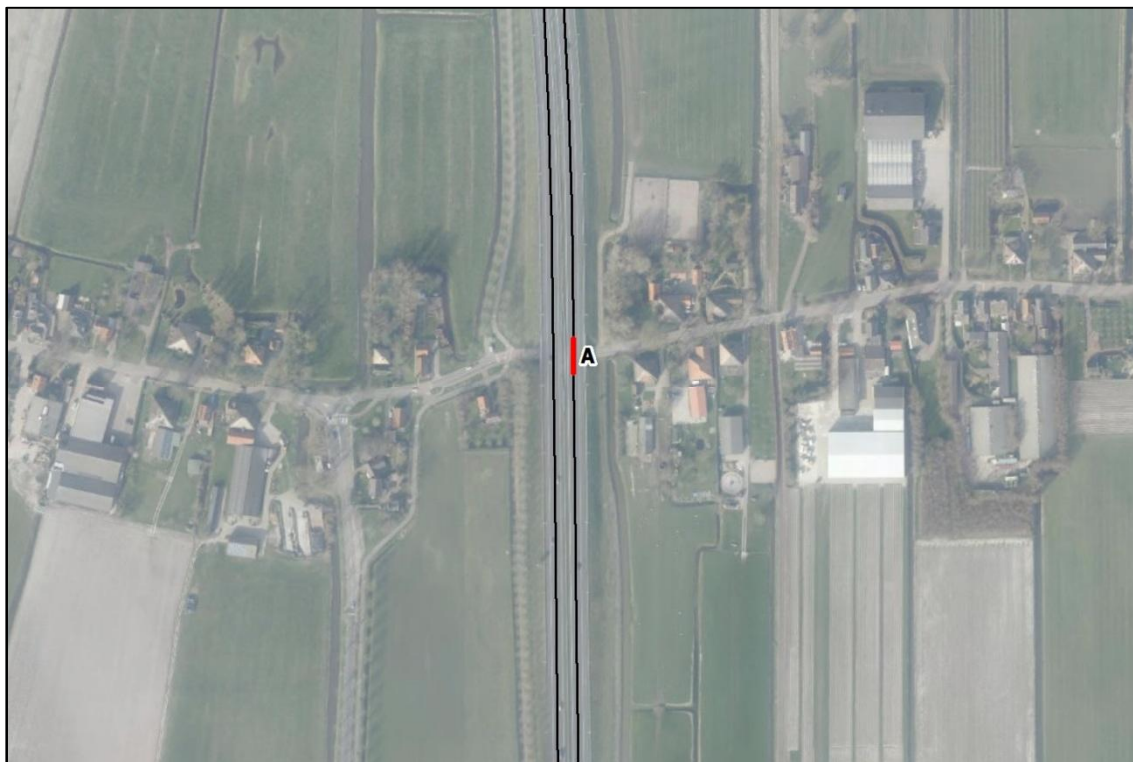
Figuur 6: Ligging wegvakken A7 t.h.v. viaduct Oosterstraat bij Benningbroek
